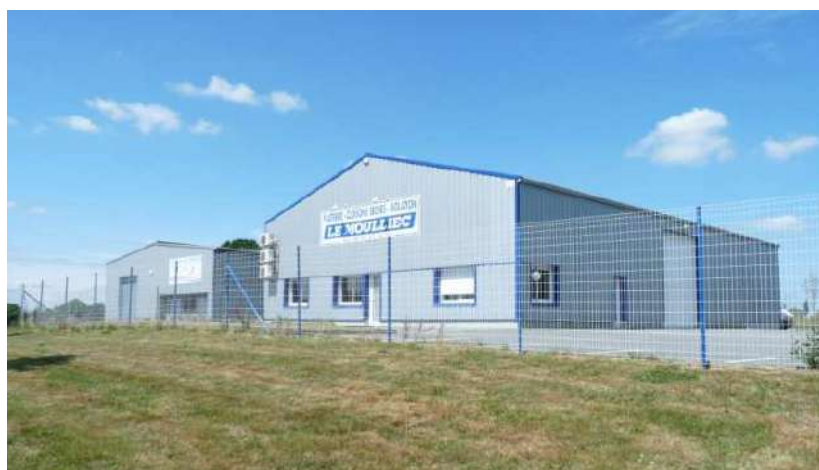
Z.I. du DOUARIN : entreprise LE MOULLIEC
